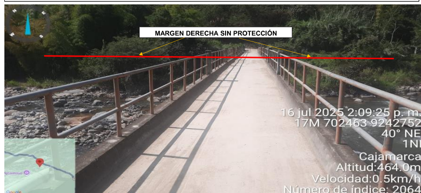
FIGURA N°03: SE OBSERVA AL PUENTE AJOSMAYO, QUE EN LA MARGEN DERECHA DEL RIO ZAÑA, SE ENCUENTRA SIN PROTECCIÓN.
